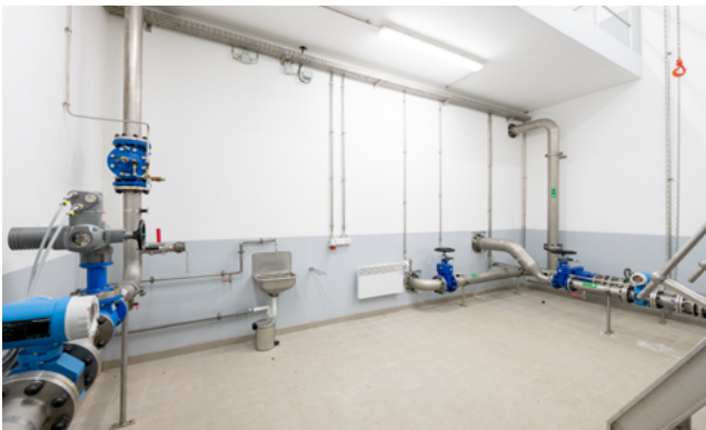
De Waasserbasseng um Fléiberg gouf 2011 ageweiht an ass de modernste Basseng an der Gemeng. Aus der lénker Leitung kënnt d'Waasser vun der Heed an d'Cuve a riets geet d'Leitung an d'Duerf.
