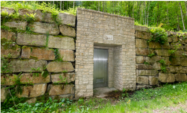
Dräi Quelle ginn um Cloosbiérg ugezaapt an dës Waasser geet virun op den Hondsbérg geleet. An Zukunft leeft d'Waasser iwwert eng Opbereedungsstatioun an dem Hondsbérg op Beefort an den neie Basseng op der Heed.
