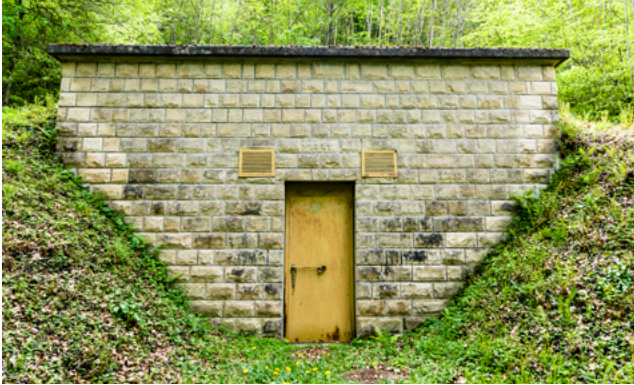
D'Quellefaassung mam Waasserbasseng fir de Grondhaff huet ee Volumen vun zéng Kubikmeter a gouf 1984 erbaut. Uewendriwwer ass eng Solaranlag fir d'Chloréierungsanlag.
