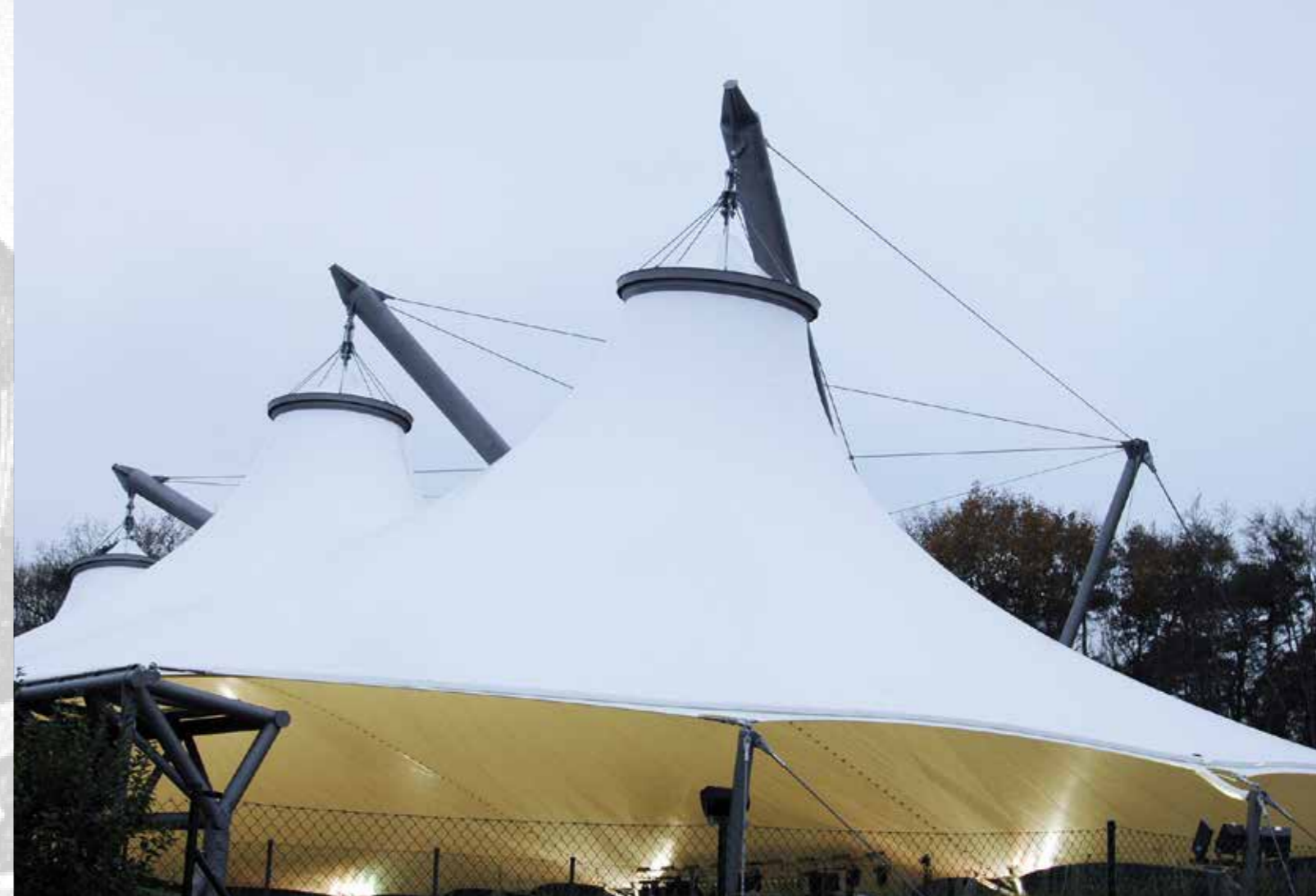
Am 11.11.11 war die Überdachung der Eispiste fertig.
