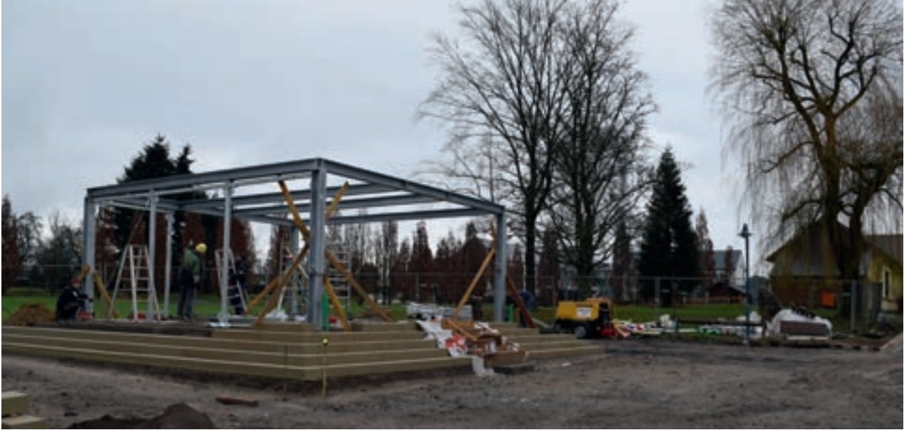
Der neue Kiosk vor seiner Fertigstellung
